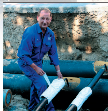
Reparatør Evan Hougaard, Aars Fjernvarmeforsyning, kontrollerer de nye rør.
