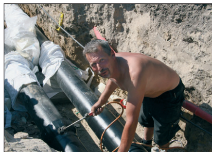
Hedebølgen først i juni fik sveden frem hos Tommy Dejligbjerg, Himmerlands VVS, som her svejser fjernvarmerør på Peder Stubbsvej.
