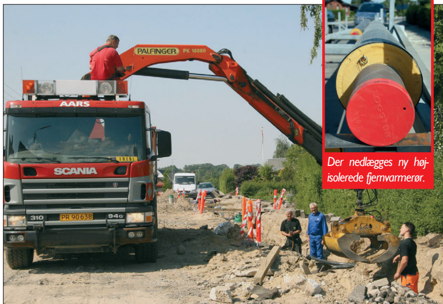
Aars Fjernvarmeforsyning har udført et stort renoveringsarbejde på Søndre Boulevard.
