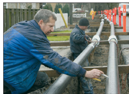
Der etableres fjernvarme på Sjøstrupbro.
