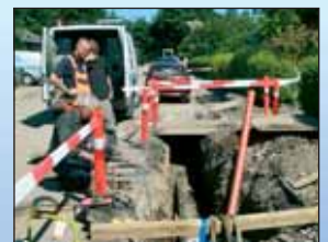
Et glimt fra fjernvarmerenoveringsarbejdet på Rørsangervej.
