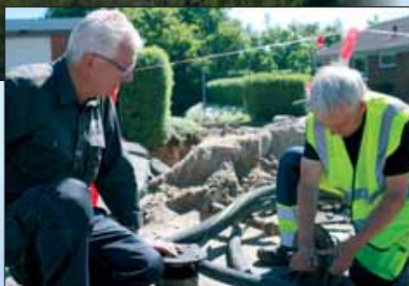
Ledningsmester Karsten Christensen, Aars Fjernvarme, sammen med rørsmed John Andersen, Vesthimmerlands VVS, på Keldgårdvej.
