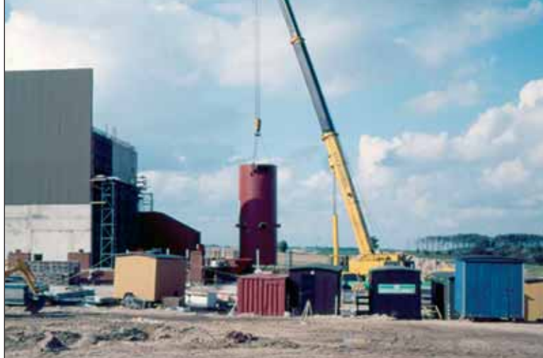
Kedlen hejses ind i Aars Varmeværk.
