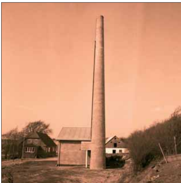
Centralen ved Oustrupvej, som nu er nedrevet.
