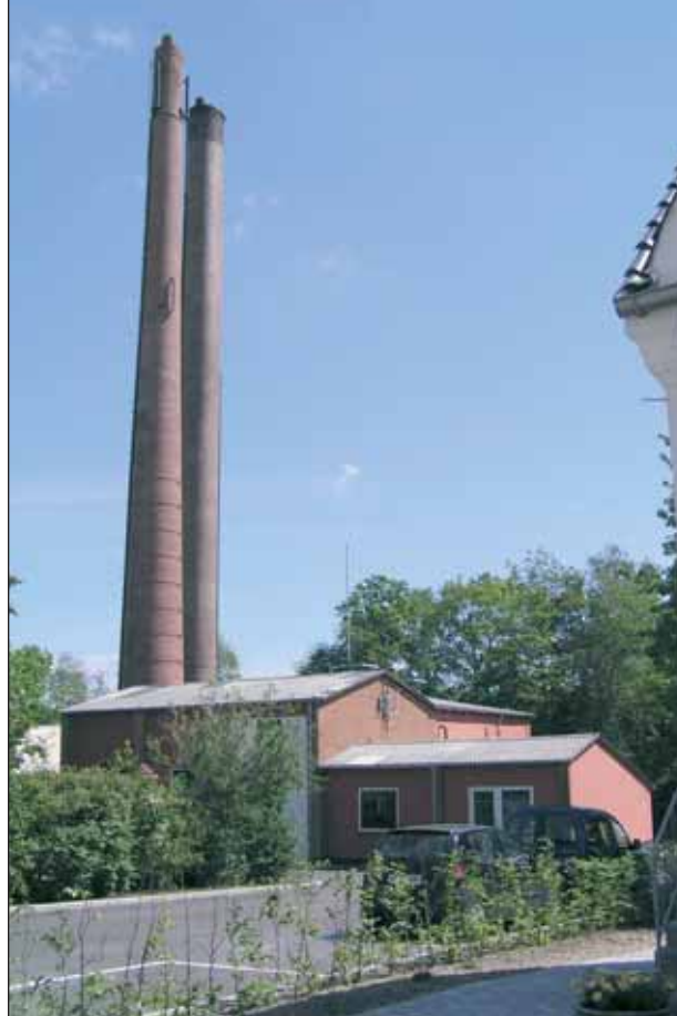
Fjernvarmecentralen på Gislumvej.
