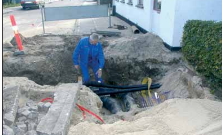
Ledningsmester Karsten Christensen arbejder på ledningsnettet ved Nibevej.
