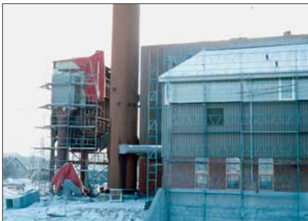
Varmeværket på Dybvad Møllevej under opførelse.
