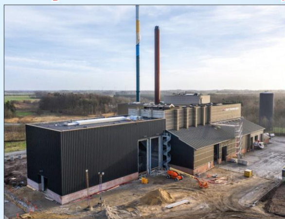
Aars Fjernvarme har fået ny tilbygning til affaldssilo, som forøger fjernvarmens lagerkapacitet med 40 procent. Tilbygningen ses til venstre.
