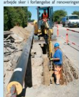
Udførelse af ledningsnet ved Kong Valdemars Vej udmunding i Østre Boulevard i Aars.
