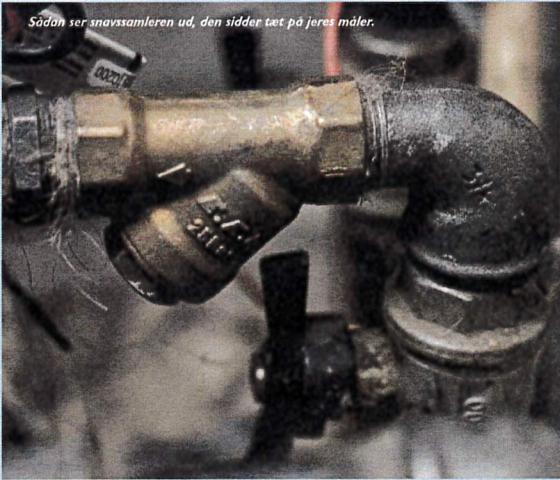
Sådan ser snavssamleren ud, den sidder tæt på jeres måler.
