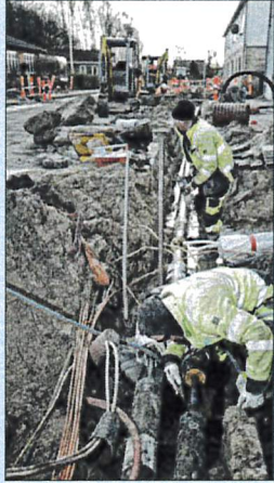
Nedgravning af fjernvarmerør.
