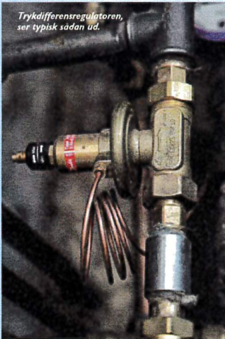
Her ses ventilen til styring af brugsvand, den ser typisk sådan ud.
