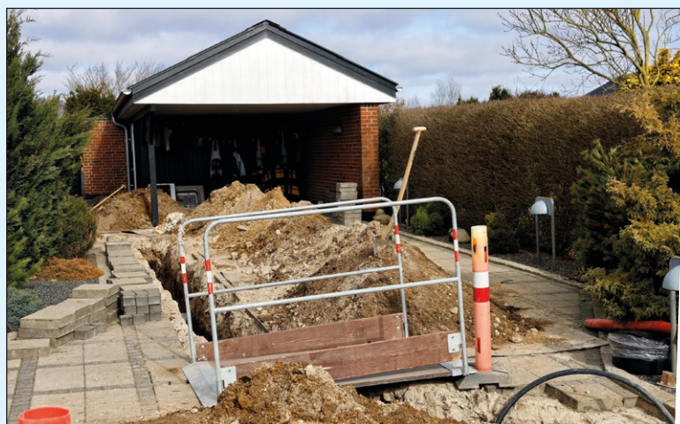
Der lægges fjernvarmerør i indkørslen.
