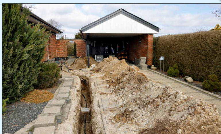
Der lægges fjernvarmerør i indkørslen.
