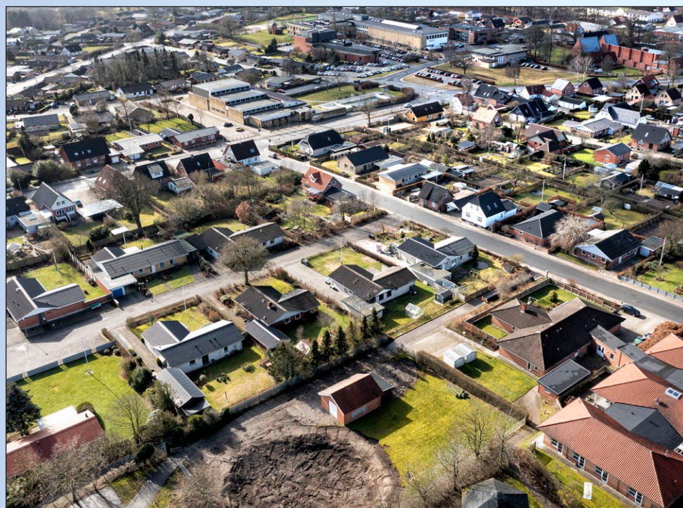
Aars Fjernvarme har overtaget det gamle vandværk på Østermarken og bygger ny central.
