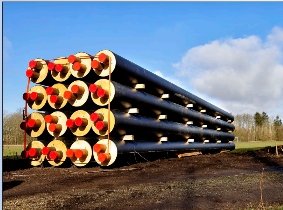
Nye fjernvarmerør klar til nedgravning.
